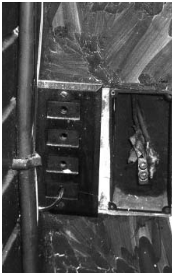
Fig. 2. Detalle de los daños sufridos, por instalación de cajetín eléctrico.
