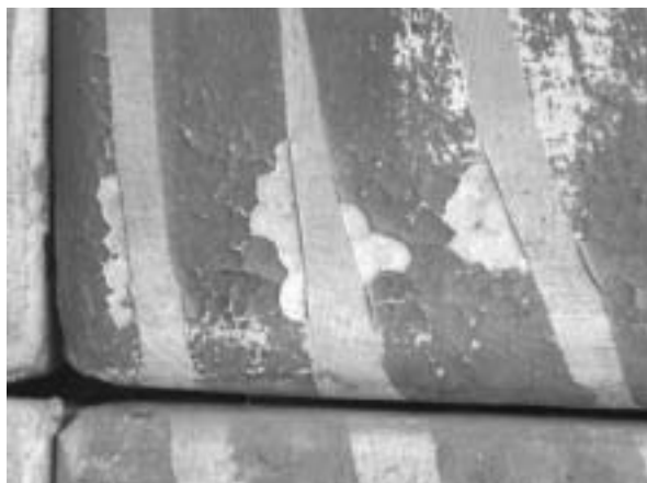
Lámina 4. Detalles de las craqueladuras y pérdidas de la capa pictórica.
